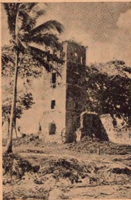
Ruinas de la torre de la Catedral Panamá vieja
